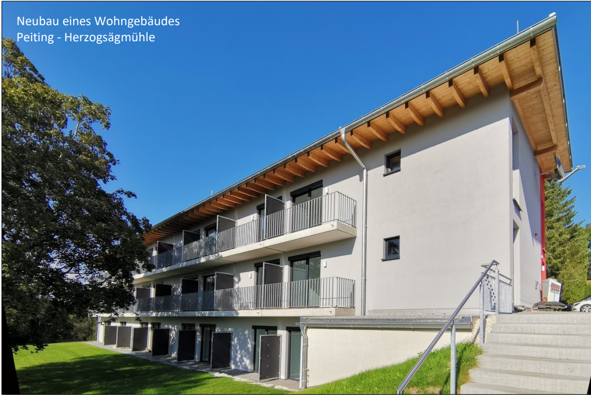
Neubau eines Wohngebäudes Peiting - Herzogsägmühle
