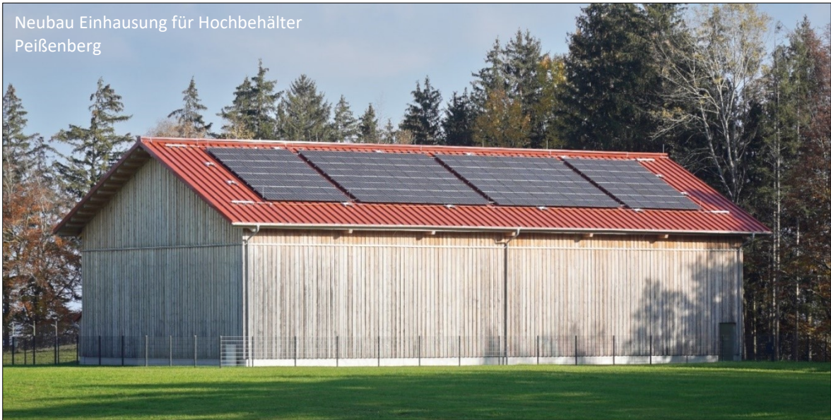
Neubau Einhausung für Hochbehälter Peißenberg
