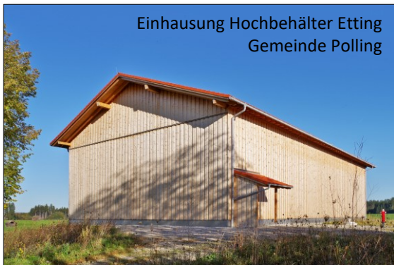
Einhausung Hochbehälter Etting Gemeinde Polling
